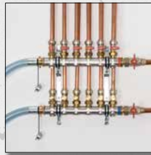
Preplachovanie radiátorov a plošných vykurovacích systémov (S/SL/SLW)
