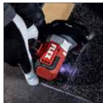
... vrubování dlaždic a přímé odsávání vzniklého prachu...
