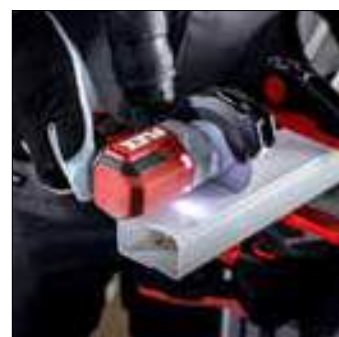
Ať už se jedná o řezání kabelových kanálů, ...
